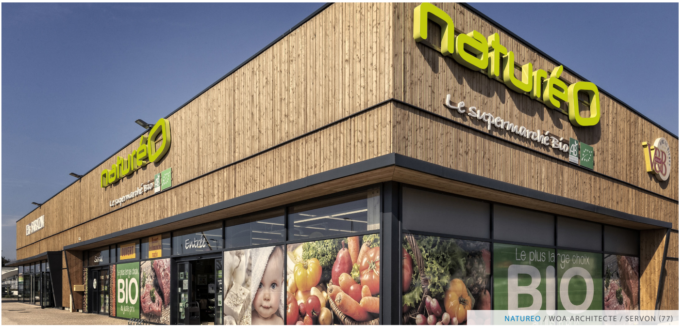
NATUREO / WOA ARCHITECTE / SERVON (77)
